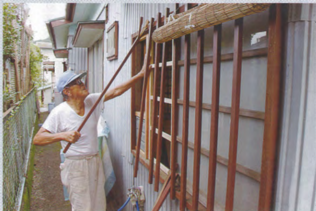
◆ 大作業（換気扇取付）
