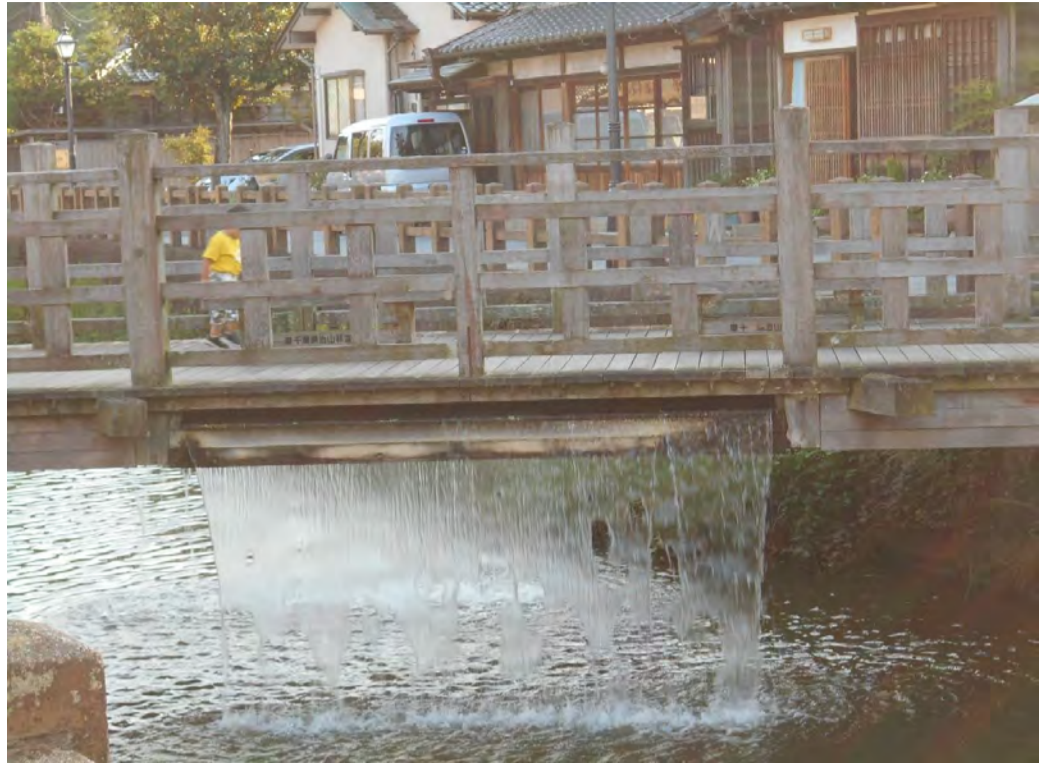
樋橋(ジャージャー橋) 環境省の「残したい日本の音風景100選」の一つ
