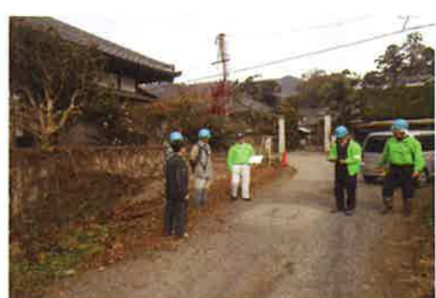
お客様を交え作業手順・安全確認
