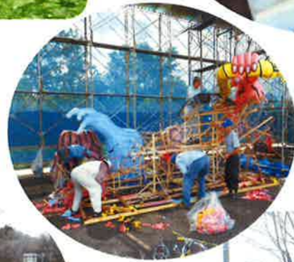
ねぶた解体作業
