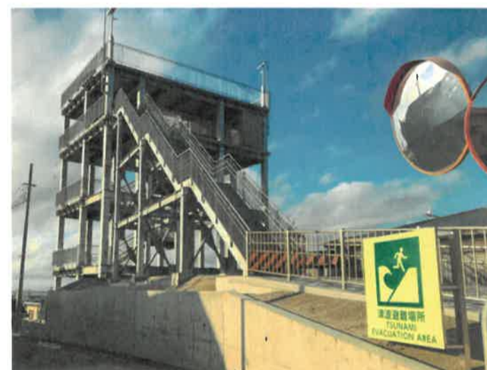
半鐘森の津波避難タワー
