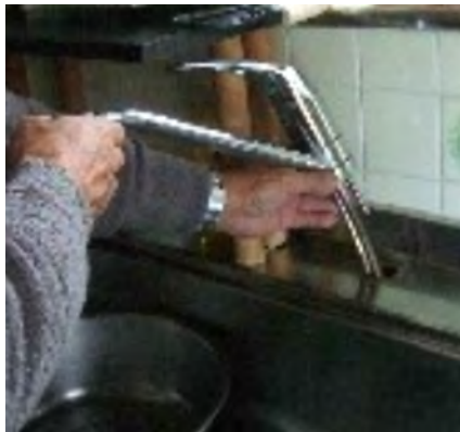
シングルレバー混合栓の交換中
